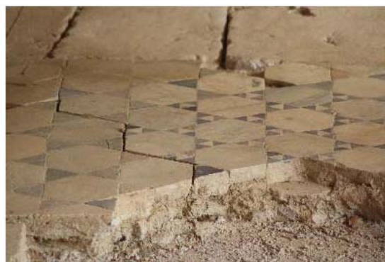
28 Porzione pavimentale della Cappella S. Restituta
